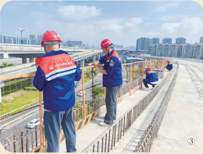
三处大瑞铁路1#斜井项目部群安员进行隧道变形量初定安全隐患排查与钢筋结构的检查作业
