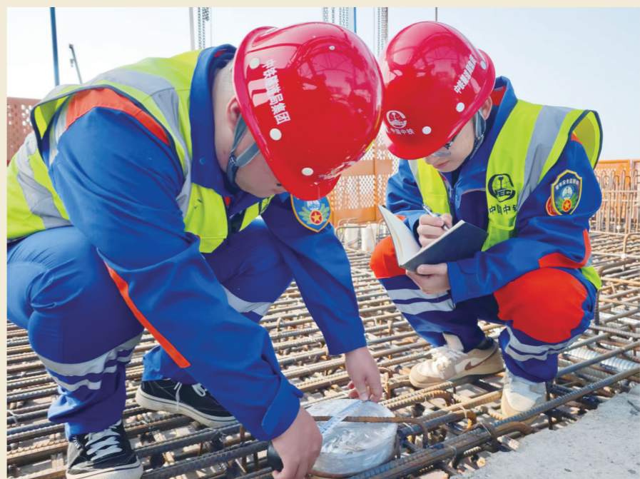
六处台州S2线7标项目部员工臂法现浇预应力混凝土连续梁桥面排“五一”期间，以责任诠释担当，用实干推进施工。因为项目青年安质岗对悬臂法现浇预应力混凝土连续梁桥面水管进行尺寸复核。蒋青青 摄影报道
