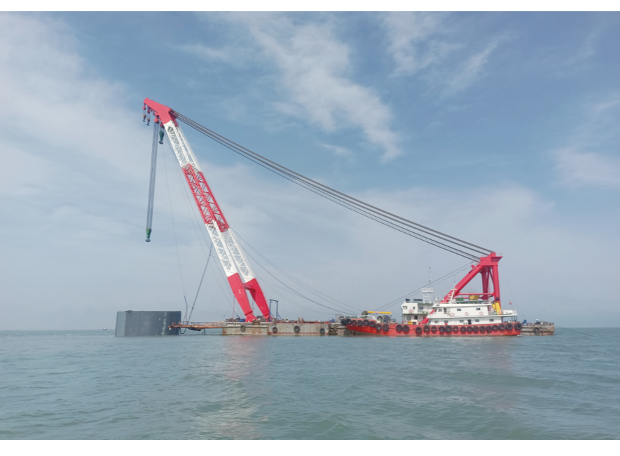
4月2日,一处施工的通州湾清洁能源项目排水头双壁钢围堰(盾构接收井)沉井精准下沉到位,标志着项目攻克了复杂海域环境下大型钢围堰下沉的技术难题,为同类工程施工积累了宝贵经验。
