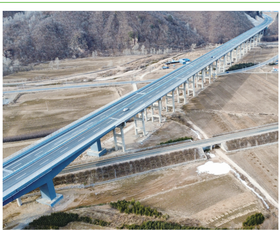
纵横山野间 (本桥高速八里甸子公铁转体桥)
